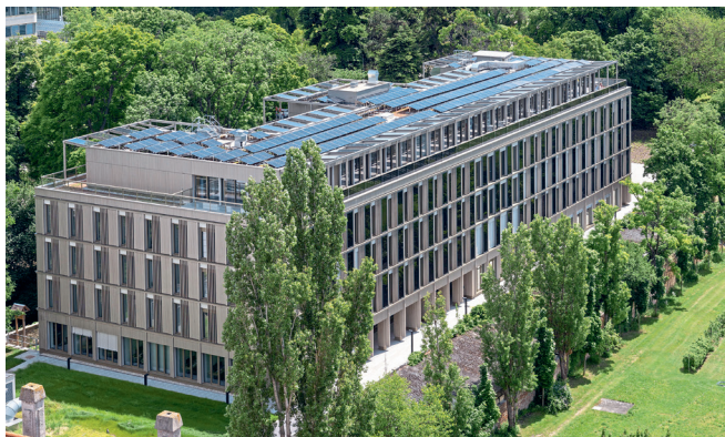
Die revitalisierte Dienststelle des Europäischen Patentamts in Wien zählt zu den nachhaltigsten Bauwerken Europas.
