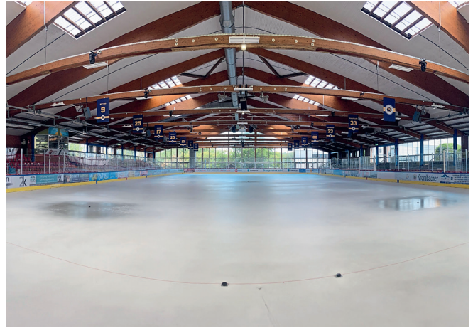
... die Erneuerung der Lüftungs- und Entfeuchtungsanlage Walter-Maack-Eisstadion sowie ...
