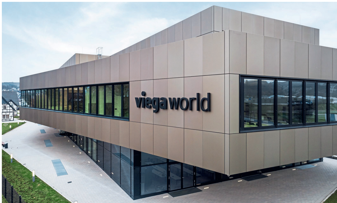
Das Seminarcenter „Viega World“ ist ein Leuchtturmprojekt für die Integrale Planung mit BIM, inklusive der Integration gewerkespezifischer Software in notwendige neue Kollaborationsprozesse.
