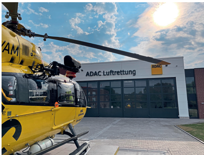
... der Neubau der ADAC-Luftrettungsstation Sanderbusch.
