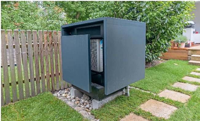
Das neue Fundament besteht aus zwei aufrecht stehenden Steinen, wodurch das Kondensat jetzt ungehindert abtropfen und im Kiesbett versickern kann.
