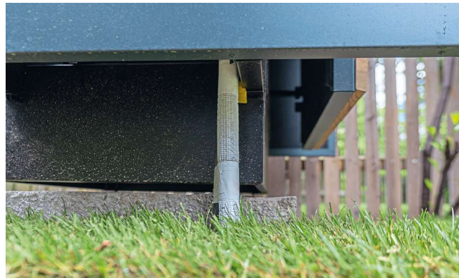
Die Rohrleitungen wurden spannungsfrei verlegt, gedämmt und das Außengerät schalltechnisch entkoppelt.
