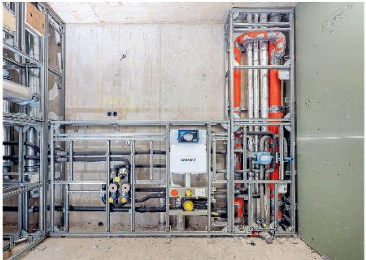
Nach der Montage aller vorgefertigten Registerelemente wurden die letzten Verbindungen der Versorgungs- und Entwässerungsleitungen verbunden.
