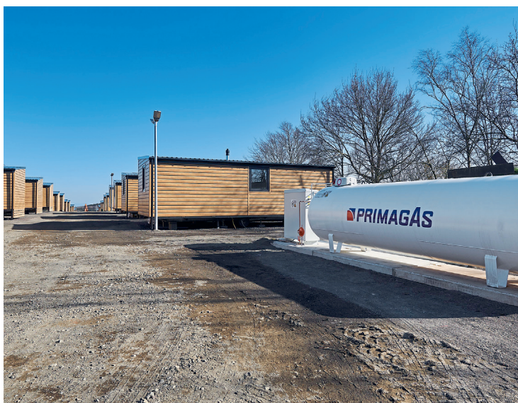
In fünf Siedlungen im Ahrtal stellte Primagas kurzfristig eine Flüssiggas-Versorgung für Heizung und Warmwasser in den Notunterkünften her.
